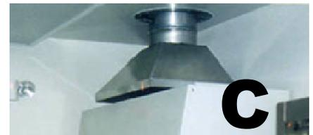
**Figura 2. Salida de aire en CSB. A) Ducto rígido de una cámara de extracción. B) Clase II tipo A2 sin ductos, se observa cubierta por una rejilla para evitar golpes a la unidad HEPA. C) Conexión abierta en dedal de imagen modificada de <http://www.certekinc.com/images/ML3-steelFridgeBig.jpg>.**
